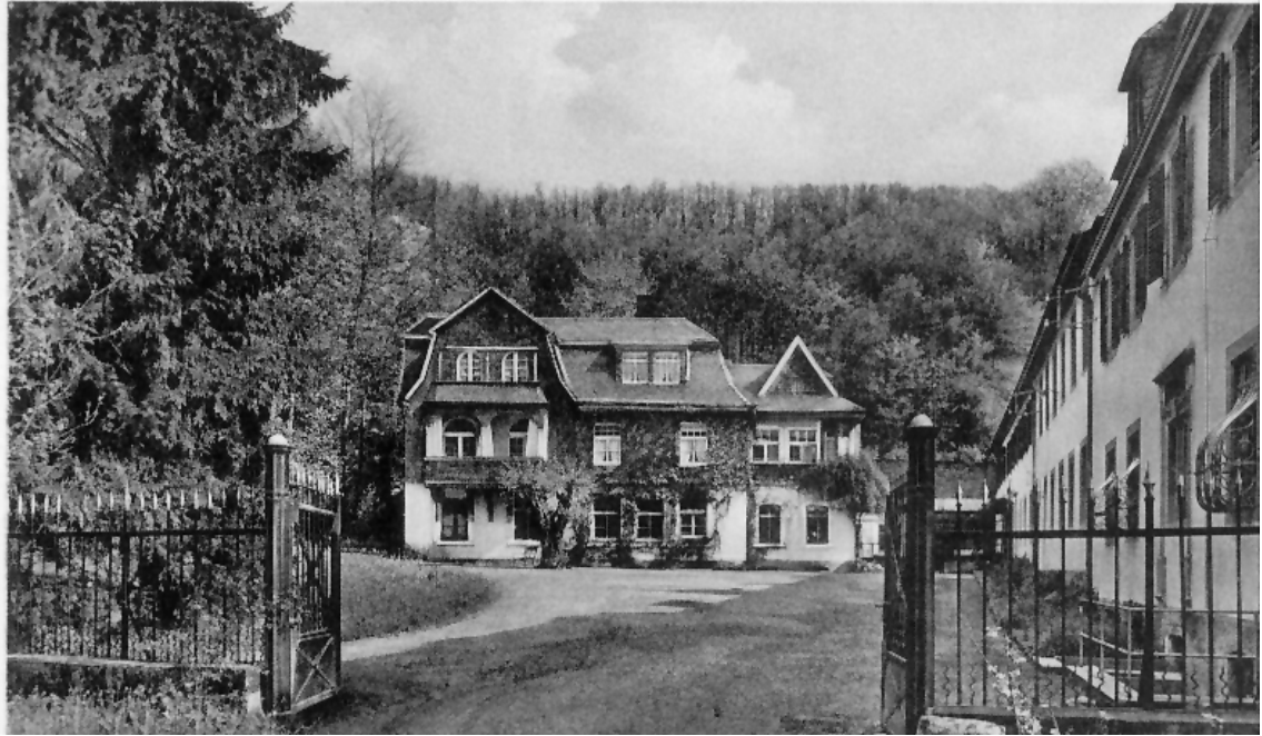
Abb 13: Die Asbacher Hütte ca. 1930
